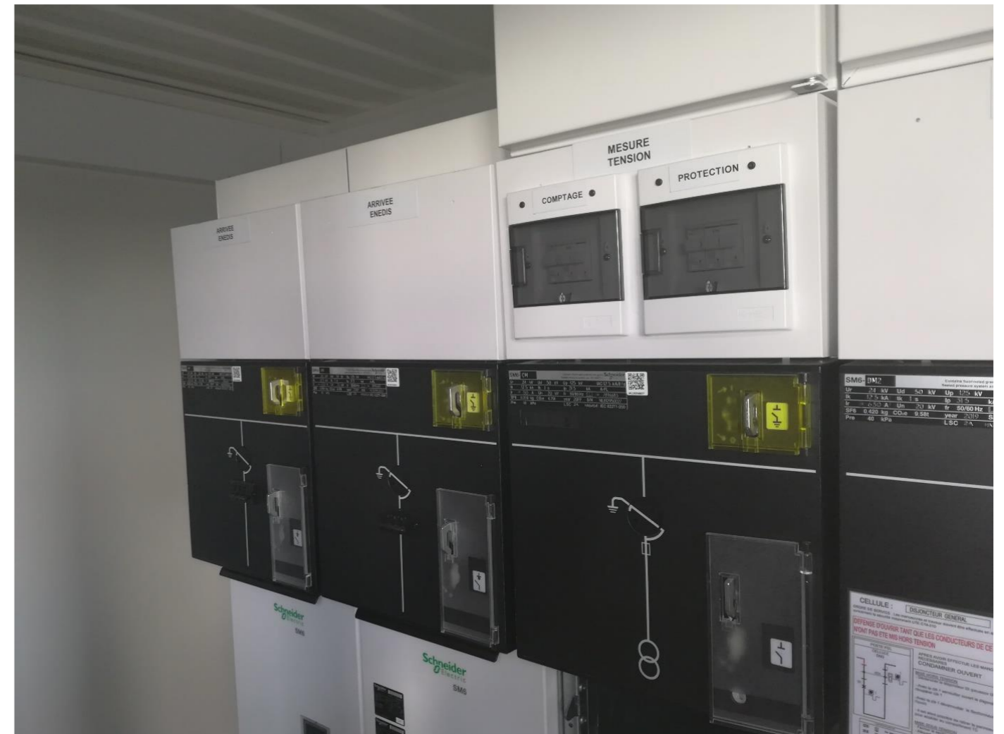
Figure 6 : Container de conversion d'énergie comprenant l'électronique de puissance et le poste HTA
