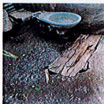
Photo 6 : Fosses pour toilette en cours de construction
