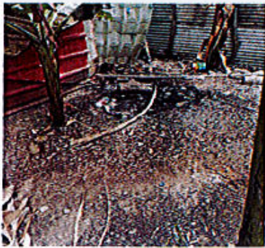
Photo 15 : Tuyau et canal crée pour l'évacuation d'eaux usées dans les habitations
