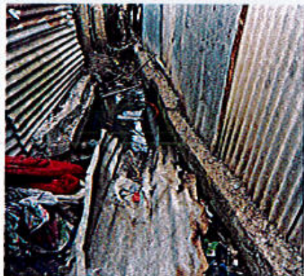
Photo 3 : Habitation avec fondation et bâti sur bord d'un caniveau d'eaux usées
