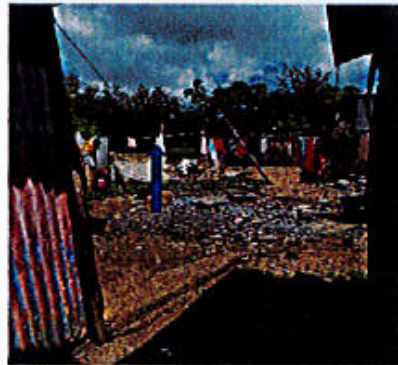
Photo 18 : Fils électriques désorganisés
