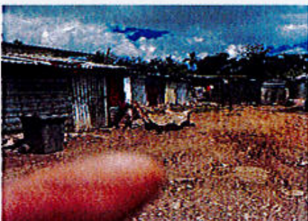
Photo 5 : Toit et Mur non jointifs
