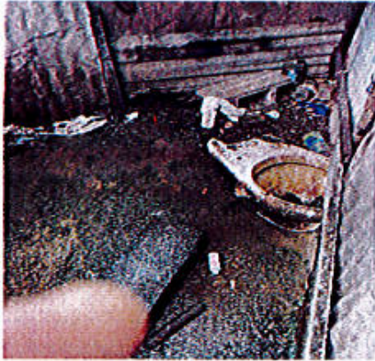
Photo 7 : Coins sanitaires extérieurs
