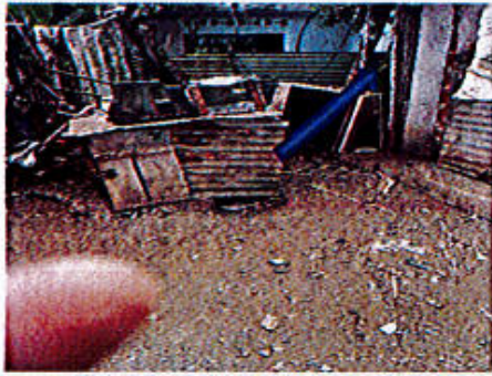
Photo 7 : Coins sanitaires extérieurs
