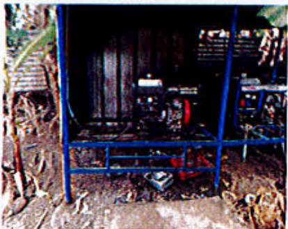
Photo 13 : deux groupes électrogènes
