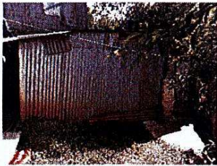
Photo 3 : Habitation sans fondation et bâti sur bord d'une ravine
