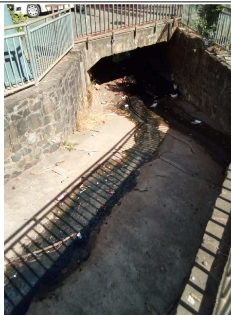
Photo 2 – Mur et radier ravine, côté aval
