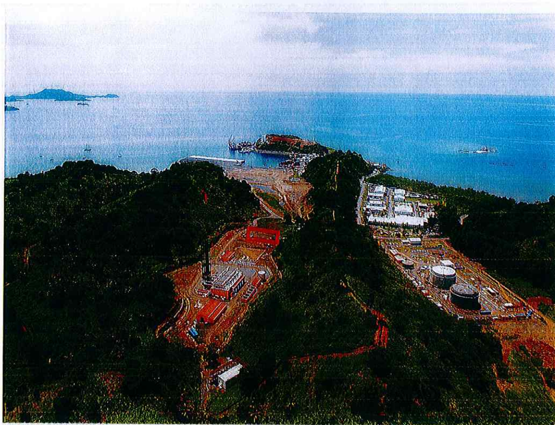
Site du projet à Longoni, commune de Koungou
