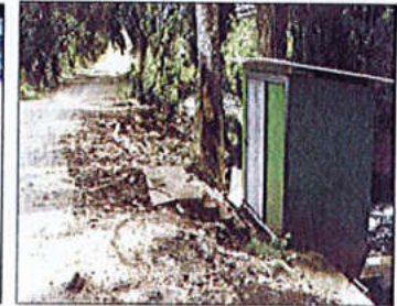
Photo 4 : Seuil de Bouyouni Bas, juin 2003 Photo Olivier Jossot, BRGM Mayotte
