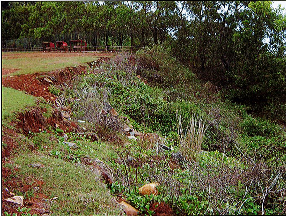
Illustration 5 – Glissement de Novembre 2004 (Source : SEGC MAYOTTE)
