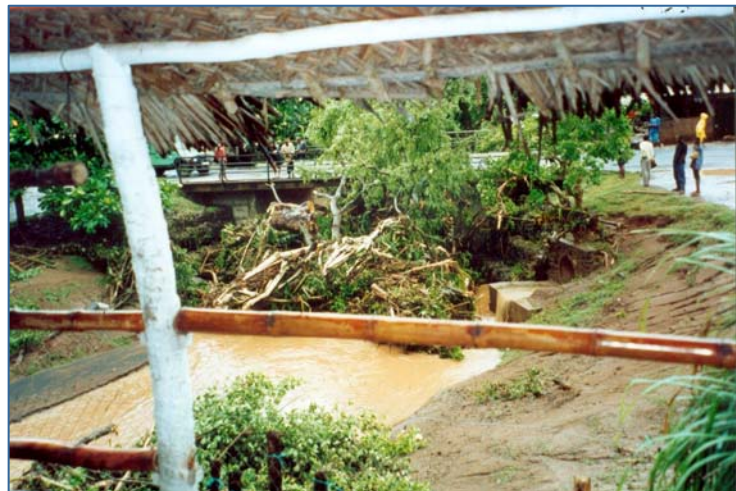
Exemple d'embâcle de branchages sous le pont de Bandrélé, le 7 mars 2001. © F. Bouttemy.
