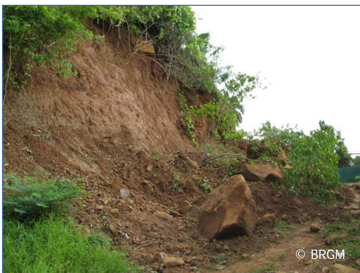
Les fortes pluies de la tempête FAME (fin Janvier 2008) ont entraîné des glissements de terrain accompagnés de chutes de blocs
