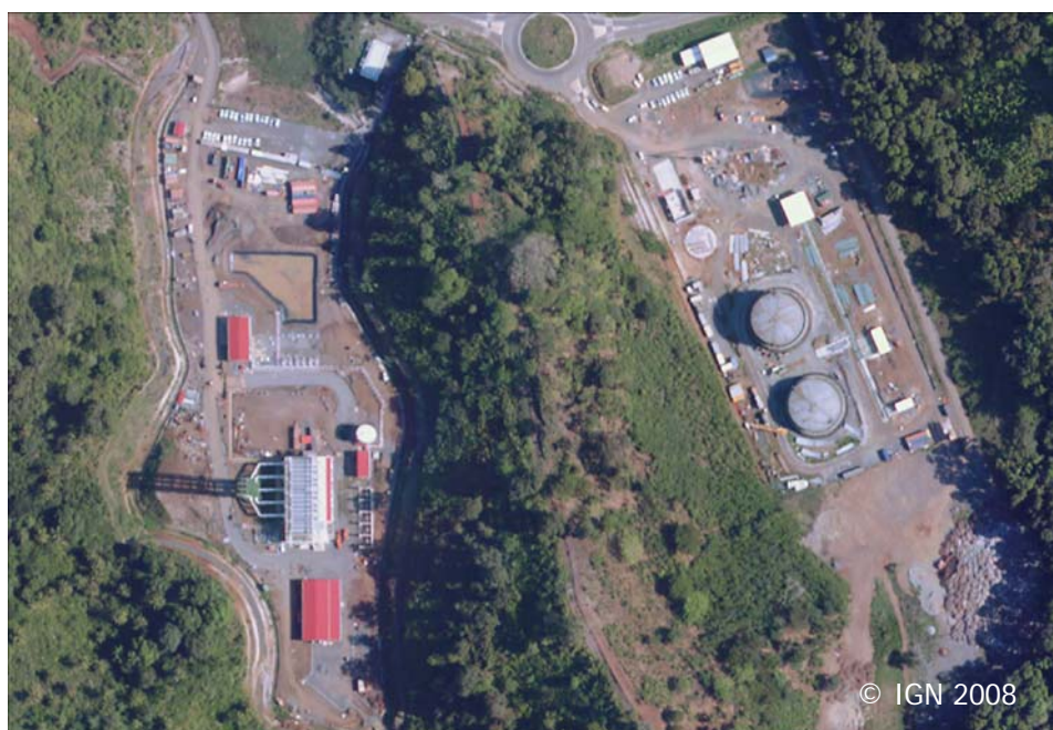
Site industriel de Longoni (commune de Koungou). Centrale EDM et dépôts d'hydrocarbures de la SMSPP (TOTAL).
