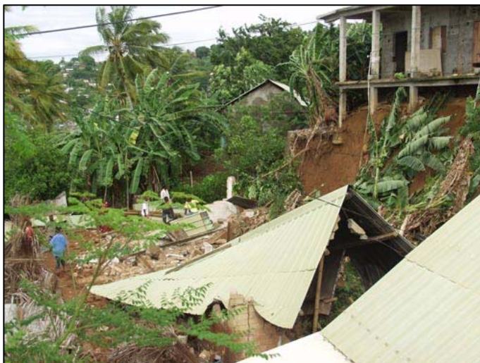
Maisons effondrées suite au passage du cyclone Gafilo (2004) faisant 3 victimes.
