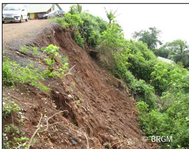
Glissement de terrain mettant en danger la voirie.
