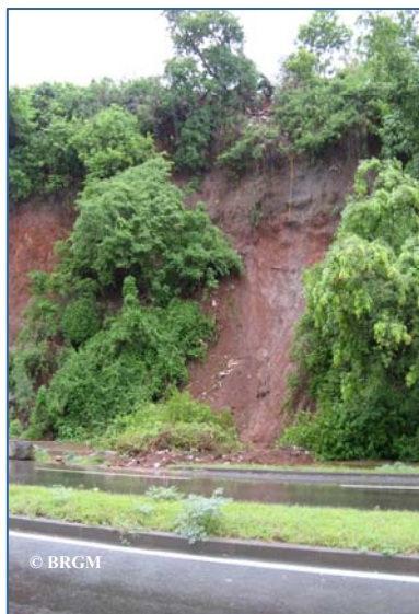
Exemples de glissements : glissements de terrain dans le talus d'altérites de la RN1 à Passamaïnti (à gauche) et éboulement récent (Avril 2008) sur les pentes du dôme de phonolite, village de Chiconi (à droite).
