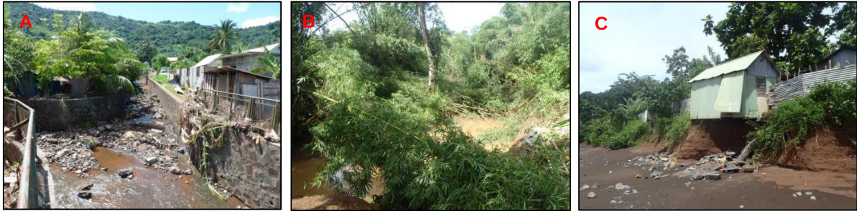
A : Laissez de crues sur le garde-corps du canal dans le centre-ville d'Acoua ; B : Embâcles formés par les bambous dans le lit de la rivière en amont du pont de Dzoumogné ; C : Affouillement sous une habitation en tôle (village de Nyambo- Bandraboua).
