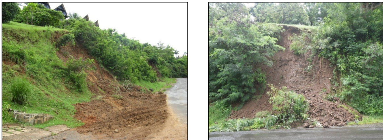
Illustration 7 - Glissements de terrain d'octobre 2007 et mars 2012 à Cavani (sources photographies BRGM)
