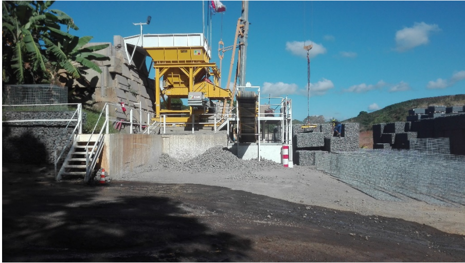
Machine de remplissage des gabions (SKAKOGAB)
