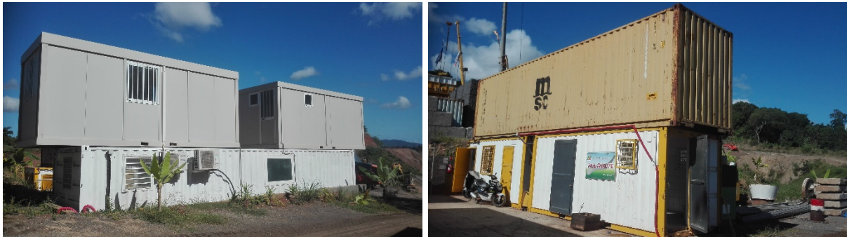
Containers aménagés installés sur le site
