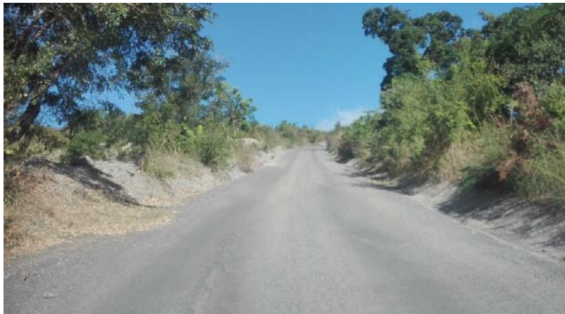
Piste privée reliant la carrière au site de concassage de Kangani
