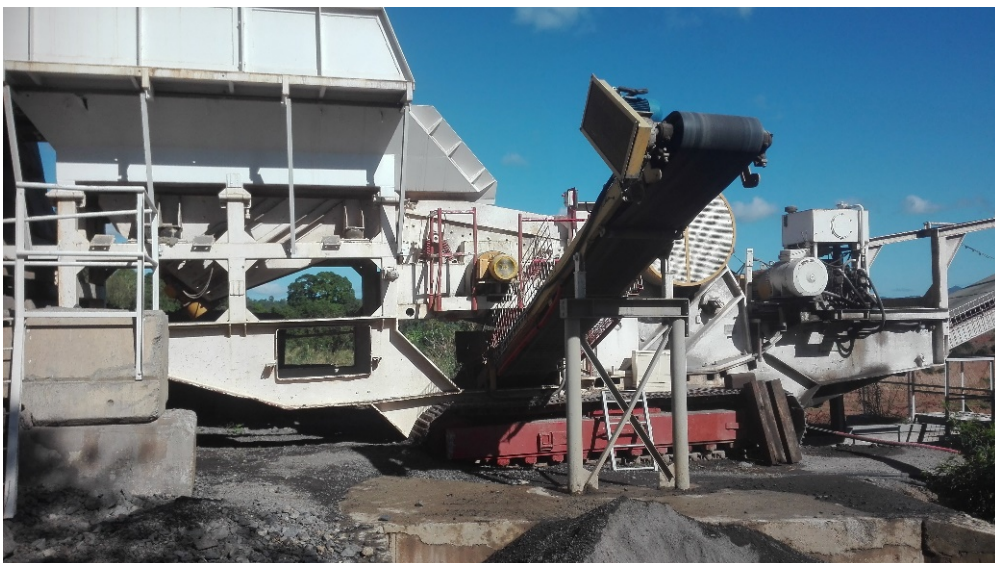
Vue d'un concasseur primaire Kleeman Reiner qui alimente la machine à gabions
