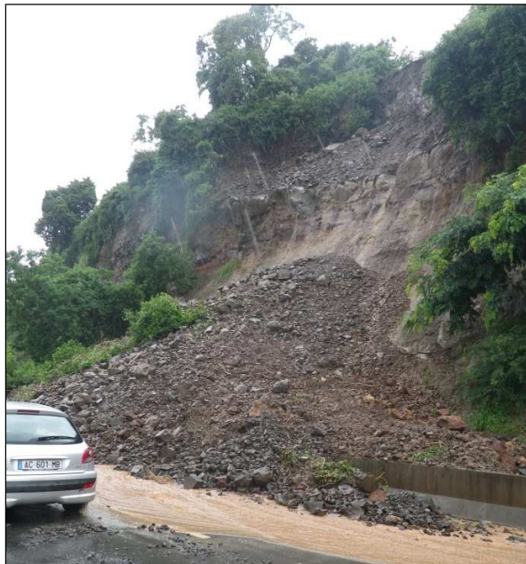
Illustration 7 - Glissements de terrain du 8 février 2012 sur la RN1 à proximité de Koungou (sources photographies BRGM)
