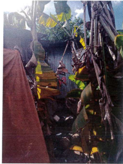
Photo n°10 : construction dépourvue de fondations, entourée de végétations.
