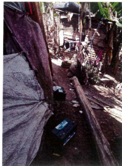
Photo n°2 : cheminements étroits et tortueux, difficulté d'évacuation en cas d'urgence, présence de batterie de voiture.
