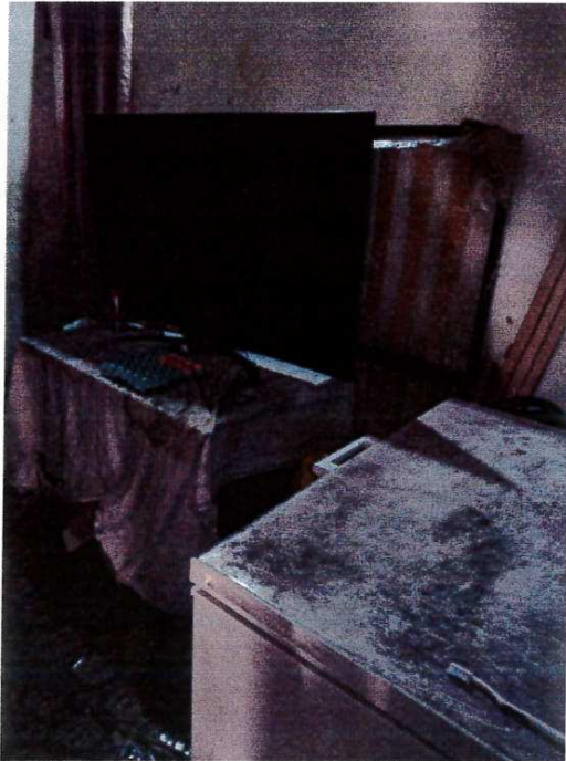
Photo 13 : intérieur construction en dur.
