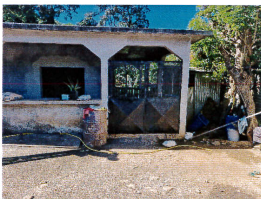
Photo n°5 : construction en dur
