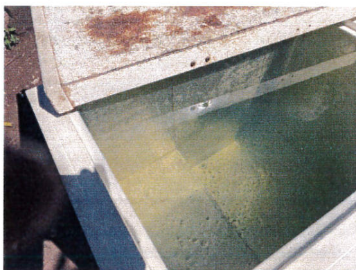
Photo n°13 : contenant d'eau non hermétique
