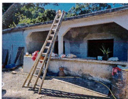
Photo n°6 : construction en dur
