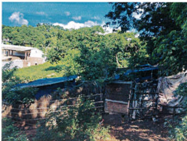
Photo n°1 : Construction en tôle à proximité de l'école en arrière-plan
