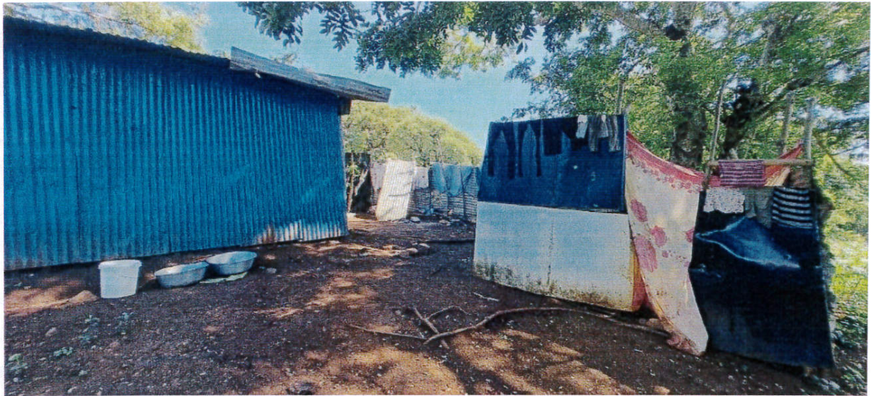
Photo n°12 : Local à usage d'habitation (à gauche) et local sanitaire (à droite)
