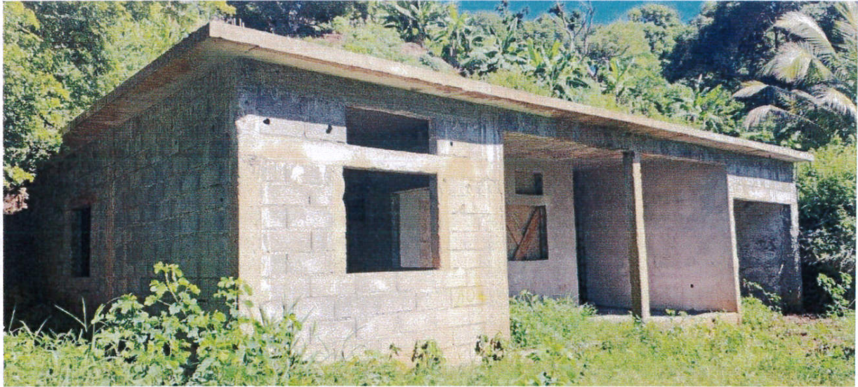
Photo n°17 : Local n°104 : construction en dur non finalisée
