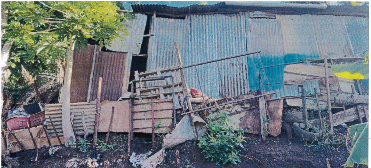
Photo n°7 : Amas de matériaux divers formant un mur de soutènement
