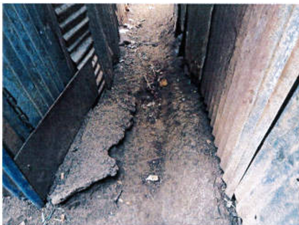
Photo n°3 : érosion, sols non plans, risques de chute
