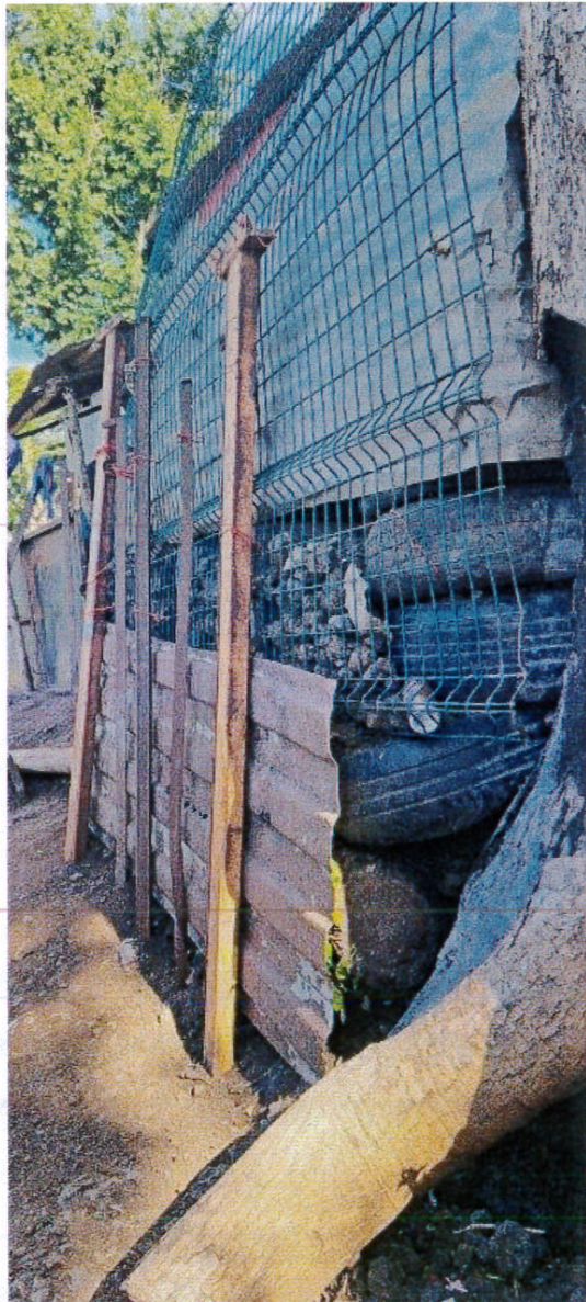
Photos n°13 et 14 : Aménagement permettant le soutènement d'une terrasse à l'entrée du local n°85
