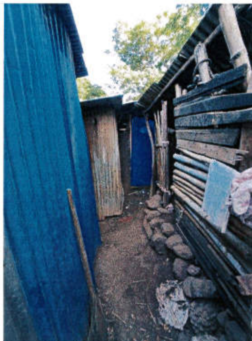
Photo n°2 : cheminements étroits et tortueux, difficulté d'évacuation en cas d'urgence
