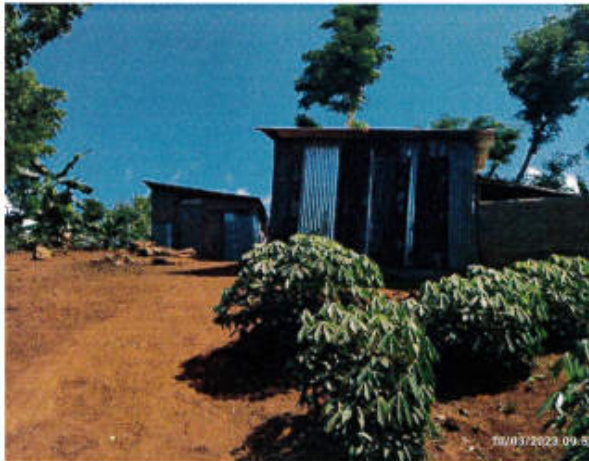
Photo n°11 : constructions précaires sur terre battue
