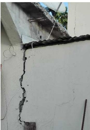
Le crayon passe dans la fissure et/ou la fissure se voit des 2 côtés du mur :
