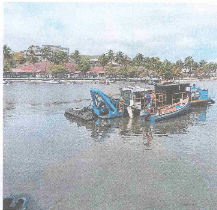
Le chantier du port du Vauclin, en Martinique, pourrait largement dépasser les deux mois initialement prévus.
