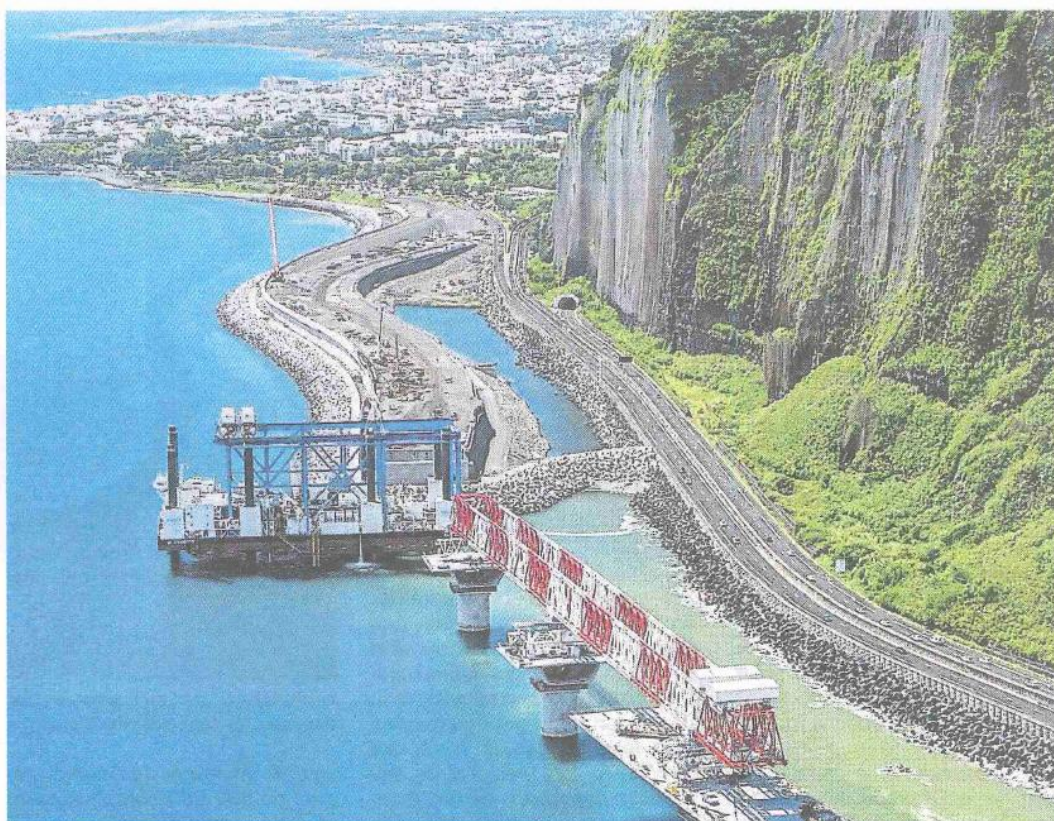
La 48 e et dernière pile du viaduc a été posée le vendredi 15 mars.
